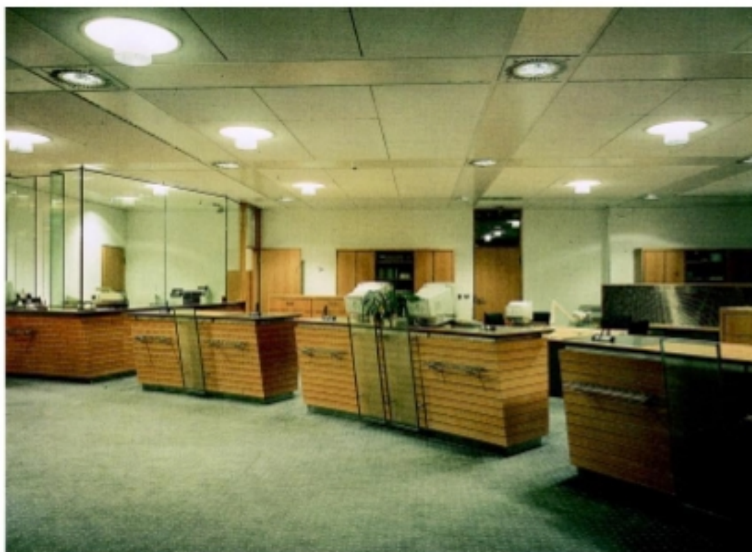
德国哈斯菲尔法地区储蓄银行 INDULCLIP ICS400 型吸顶式出风口，矿棉板吊顶
