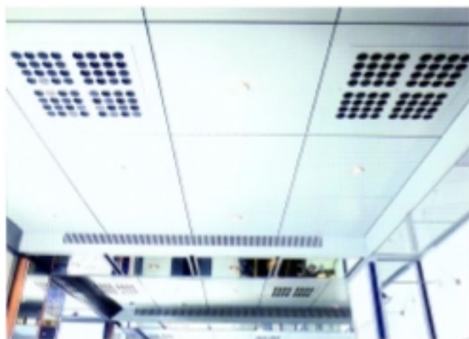
INDUDRALL吸顶式出风口V500型,金属吊顶
